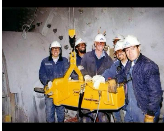
FIG N2 : Martillo bota-pernos utilizado para eyectar hacia el interior del molino el perno que sustenta el revestimiento, manipulado por un equipo de personas Consideraciones para el diseño de la máquina cortadora de pernos:
