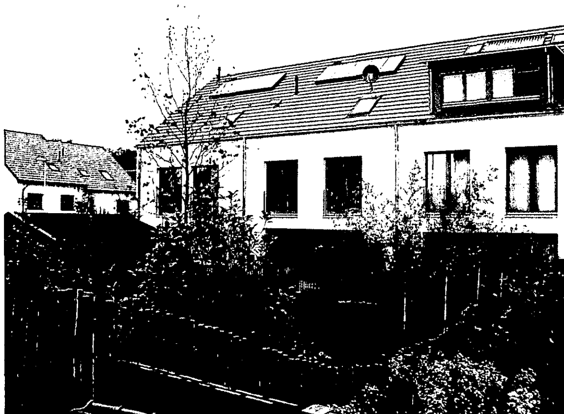
Foto 8. Vista de casa de estándar pasivo Aldea Solar Laurensberg, Aachen.
