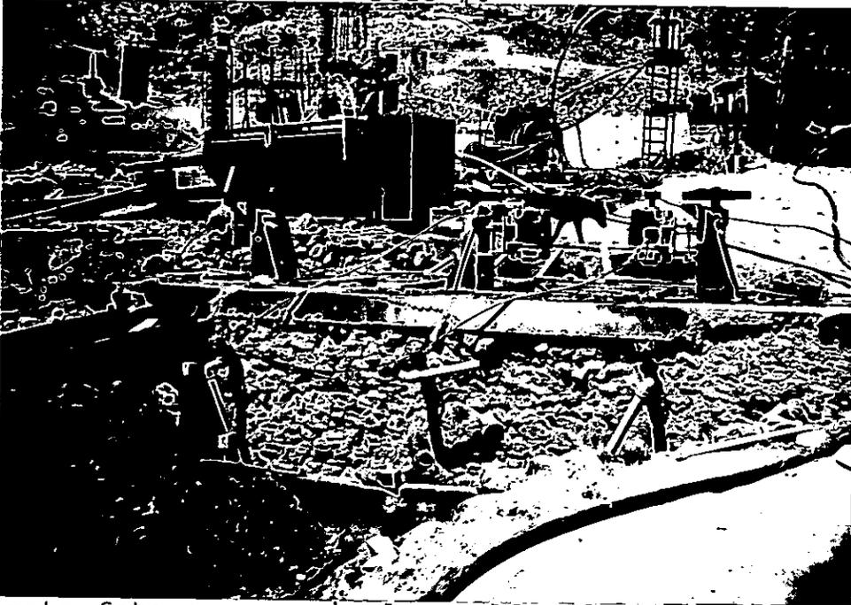
En esta foto se aprecia las celdas de flotación en la parte posterior de la imagen, y los estanques de agitación al frente en ella se aprecia los ductos de desagüe por donde se extrae el mineral ya procesado y las soluciones son retiradas por revalse.
