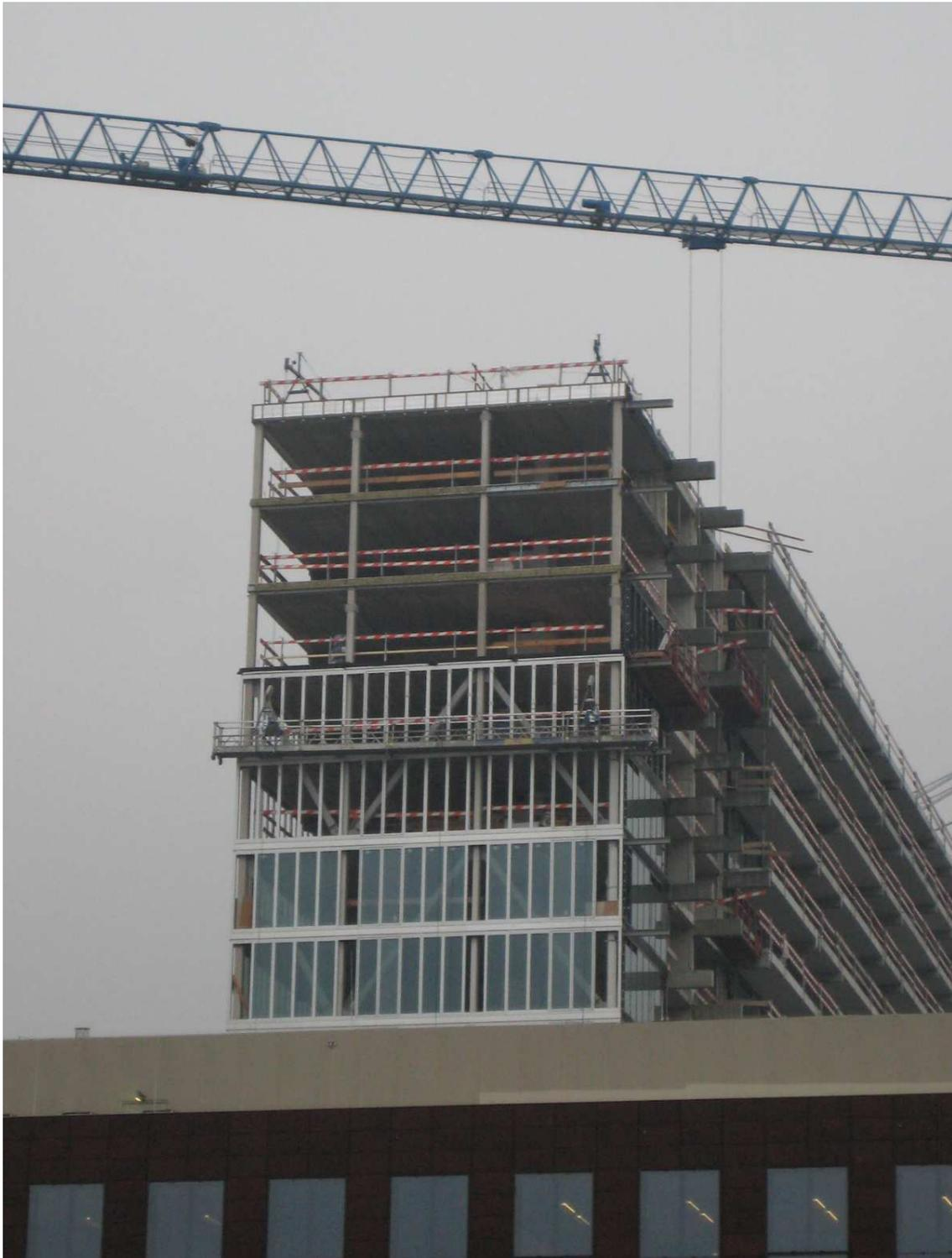
Foto 18. Edificio de oficinas en construcción. Sistema de muro cortina de alto rendimiento.
