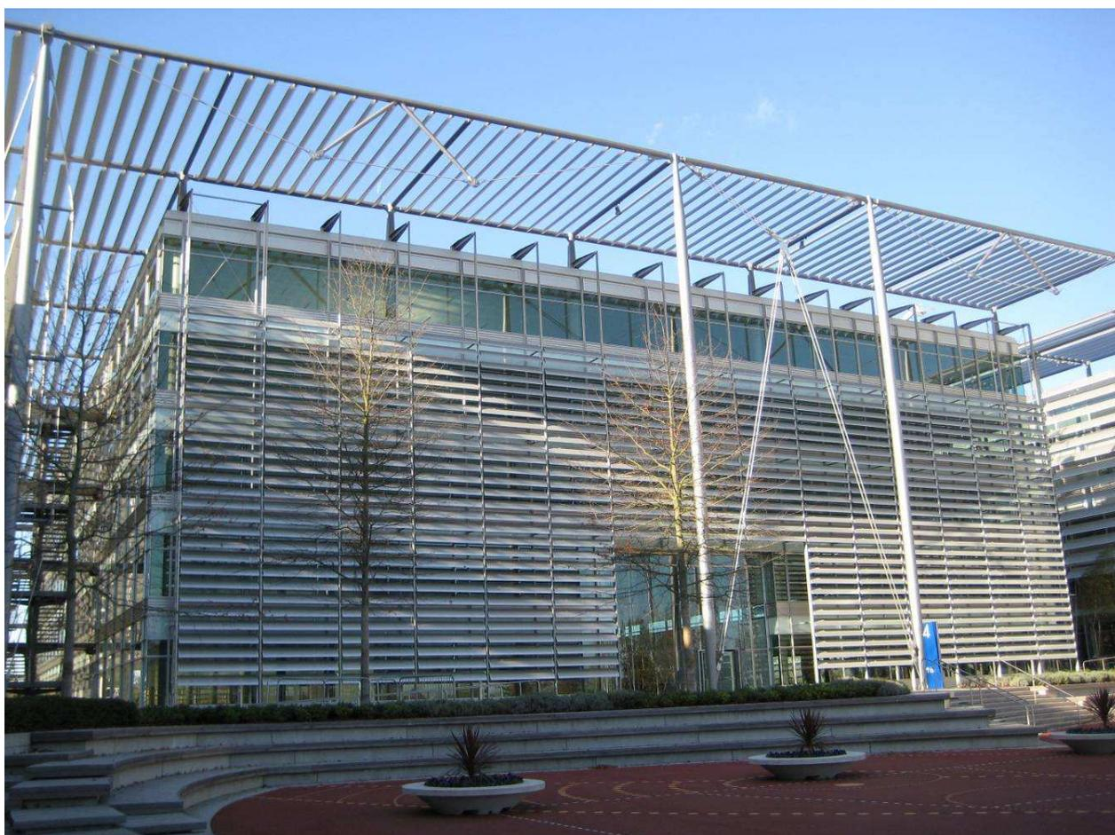
Foto 15. Sistema de quebrasoles emplazados en fachadas de alta incidencia de radiación solar.
