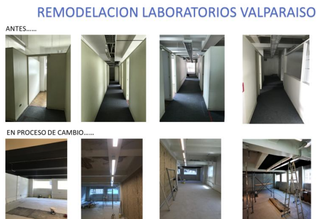
Figura 7: Remodelación laboratorios Valparaíso
