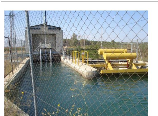
Figura 7: Minicentral, compuerta y reja con limpieza automática.
